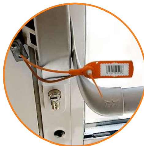
Дверь эвакуационного выхода
